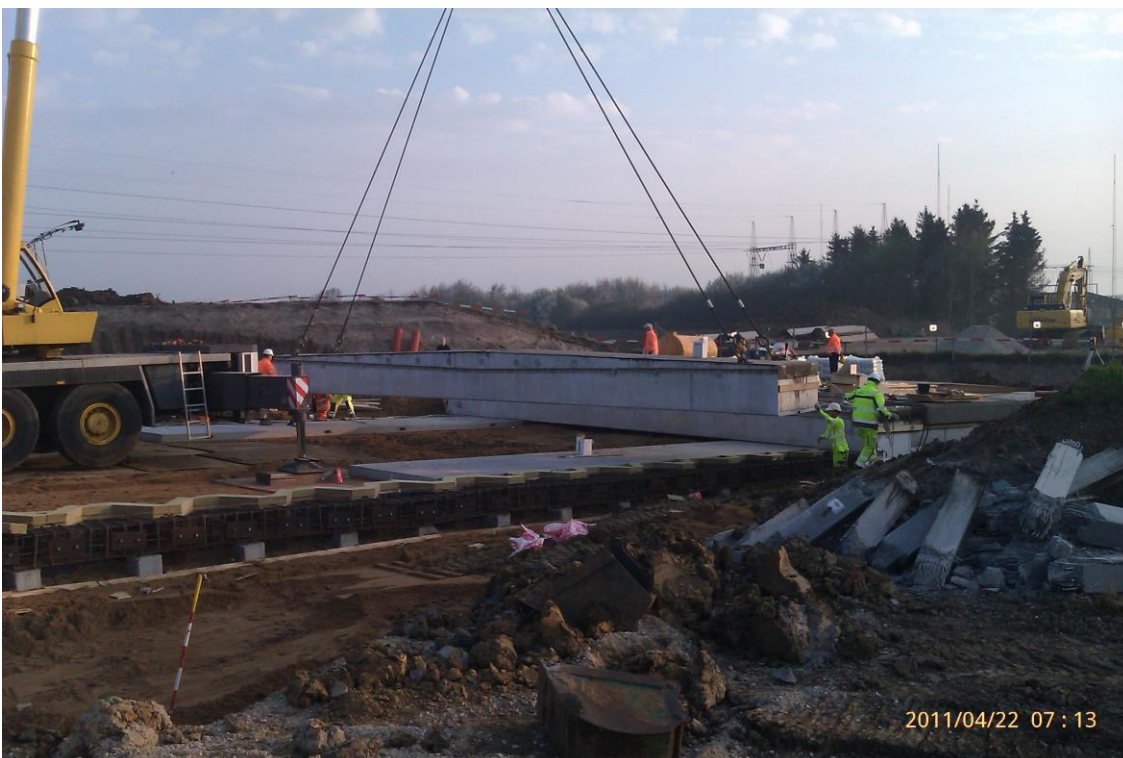
Billedtekst 3: På tredje etape blev det sidste bjælkeelement monteres 15 minutter inden det planlagte tidspunkt.
