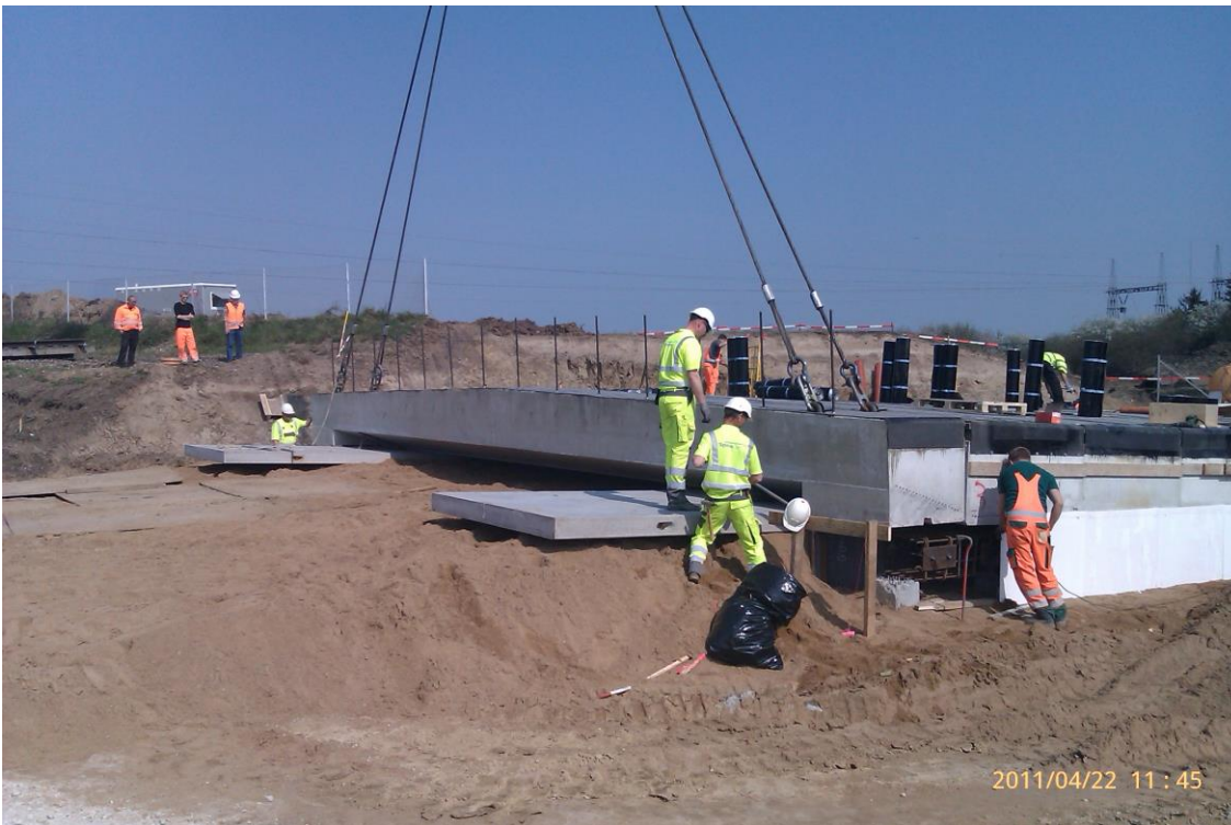
Billedtekst 2: Montage af den 38 tons tunge brobjælke
